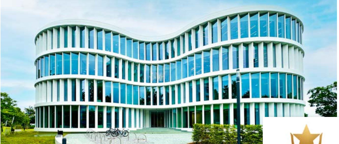
Die Fassade besteht aus 500 Fensterelementen, die sägezahnförmig in drei Kreisen angeordnet sind. Foto: M&T
