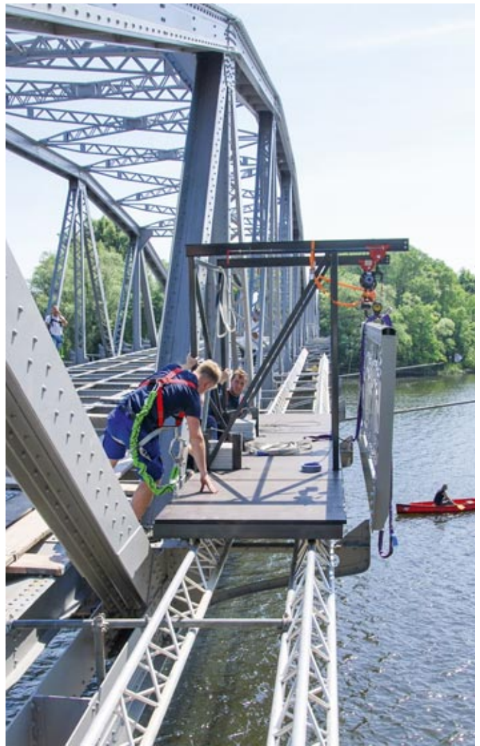
Höhenangst verboten: Um die restaurierten Geländeteile zu montieren...
