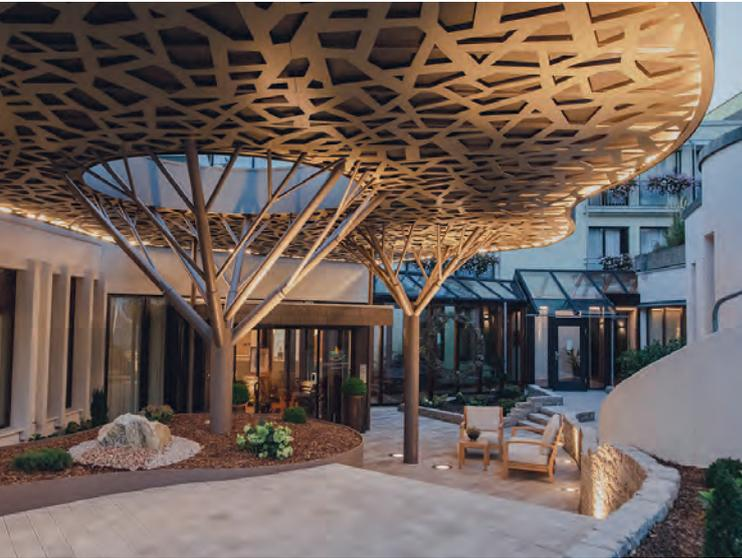
Drei mittels duroZINQ-Feuerverzinkung behandelte stählerne Baumstamm-Komponenten tragen das Baumdach. Eine Besonderheit ist die Entwässerung: Diese erfolgt innerhalb der Baumstützen und ist für den Hotelgast unsichtbar. Foto: Hotel Kunzmann's
