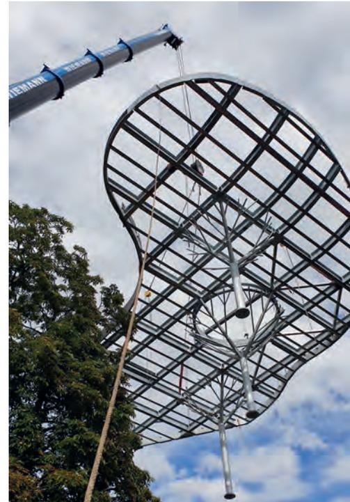
Um den Eingangsbereich so wenig wie möglich einzuschränken, wurde die Stahlkonstruktion auf dem Hotelparkplatz vormontiert in einem Hub mit einem 160-Tonnen-Autokran an ihren Bestimmungsort gehoben. Foto: Hahner Technik
