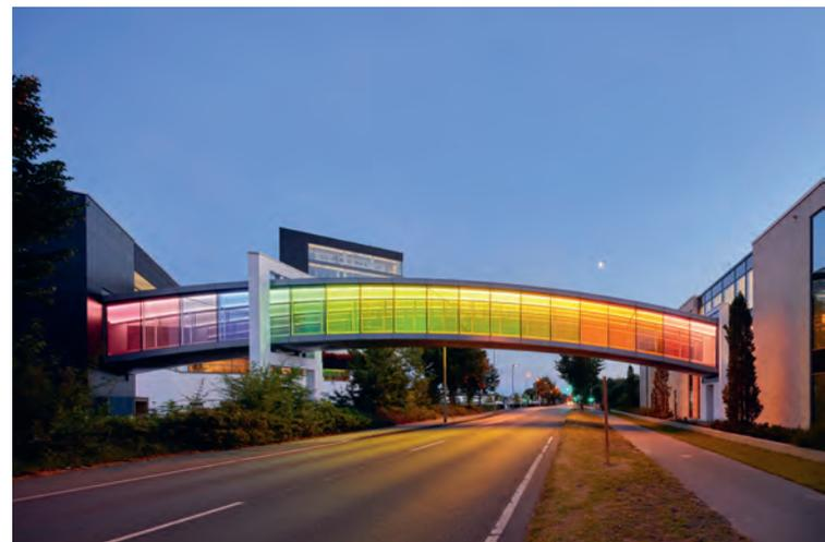
Zwei bogenförmige Stahlträger bilden die komplett verglaste Brücke. Foto: Brillux
