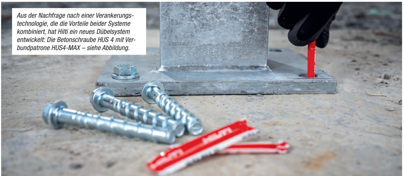
*Aus der Nachfrage nach einer Verankerungstechnologie, die die Vorteile beider Systeme kombiniert, hat Hilti ein neues Dübelssystem entwickelt: Die Betonschraube HUS 4 mit Verbundpatrone HUS4-MAX – siehe Abbildung.*
