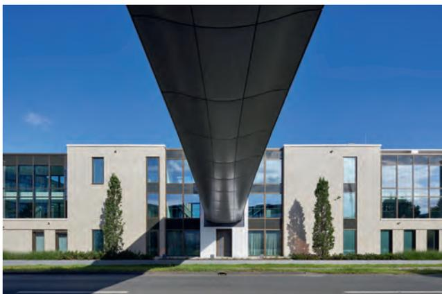
Brückenelement aus der Nähe: Die Blechverkleidungen nehmen die taillierte Form der innenliegenden Brückenkonstruktion auf. Foto: Brillux
